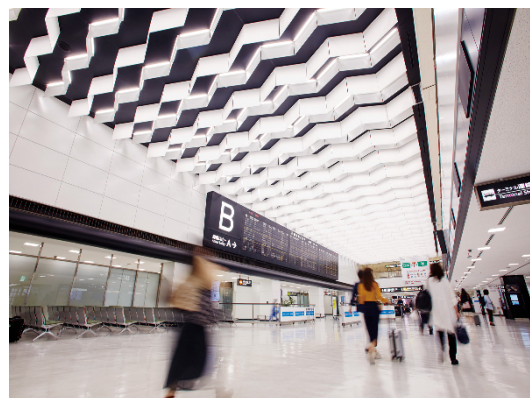
図 4.3-11 第 2 旅客ターミナルビル 国際線到着ロビー天井の LED 照明
