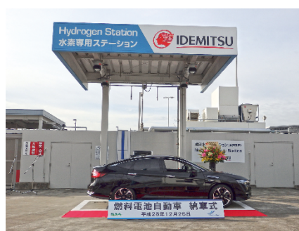
図 4.3-6 成田水素ステーション
