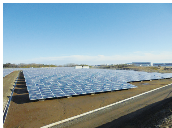
図 4.3-8 三里塚太陽光発電所
