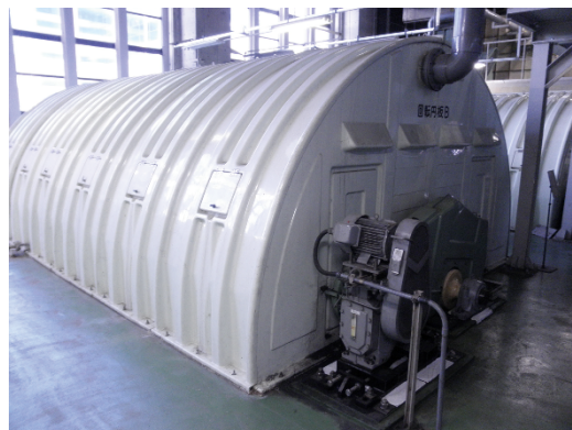
図 4.2-16 厨房排水除害施設
