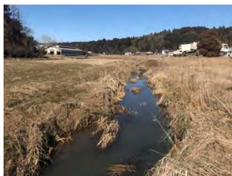
写真 11.15.3-1 傾斜型護岸箇所 (高谷川)
