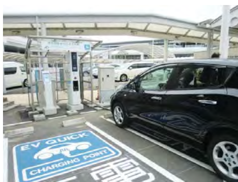
写真 10.14.2-1 電気自動車用の急速充電器
