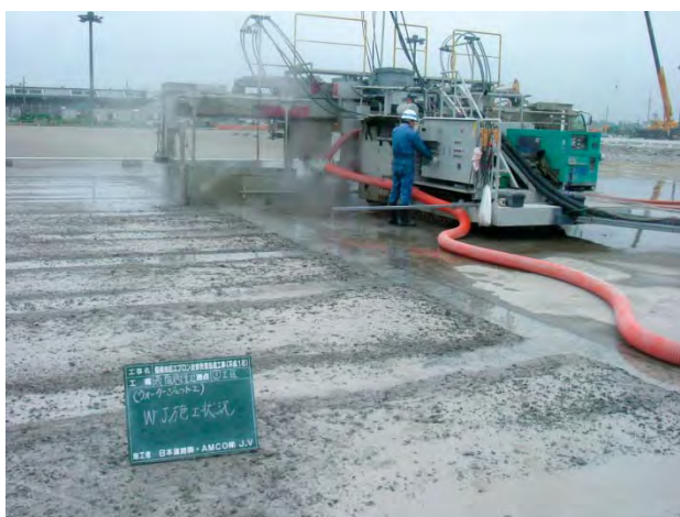
図 4.2-7 完全付着型オーバーレイ工法工事の様子
