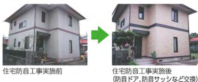
図 4.1-11 住宅防音工事の事例
