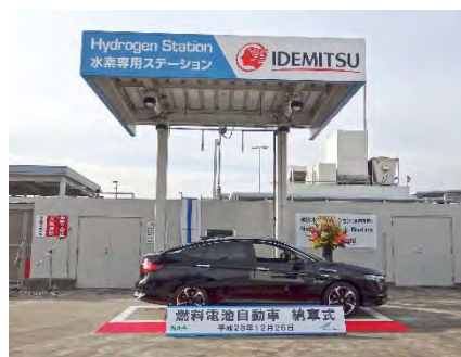
図 4.3-6 成田水素ステーション
