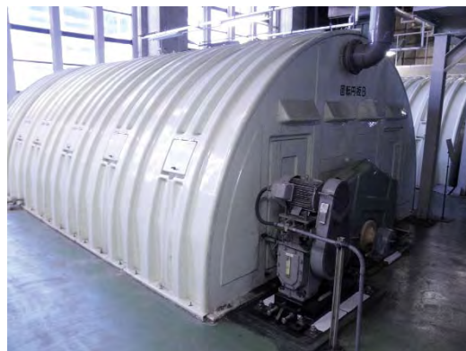
図 4.2-16 厨房排水除害施設
