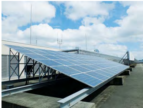
写真 10.14.2-2 太陽光発電設備
