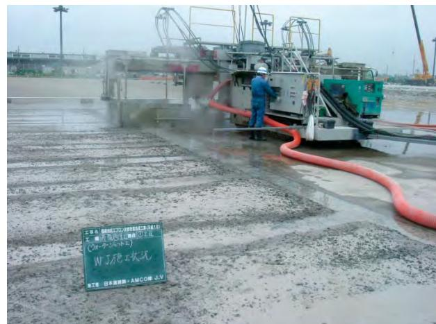
図 4.2-7 完全付着型オーバーレイ工事の様子
