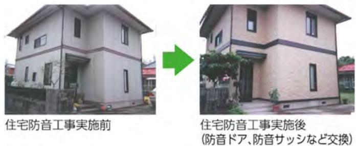
図 4.1-11 住宅防音工事の事例
