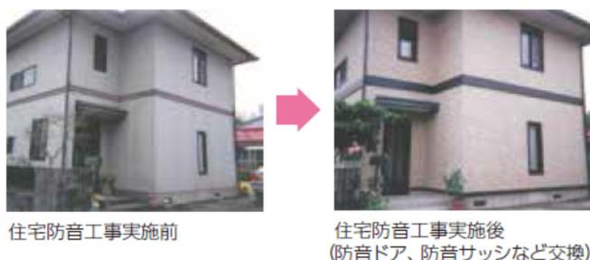
図 4.2-12 住宅防音工事の事例
