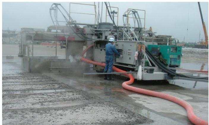
図 4.3-13 完全付着型オーバーレイ工法工事の様子
