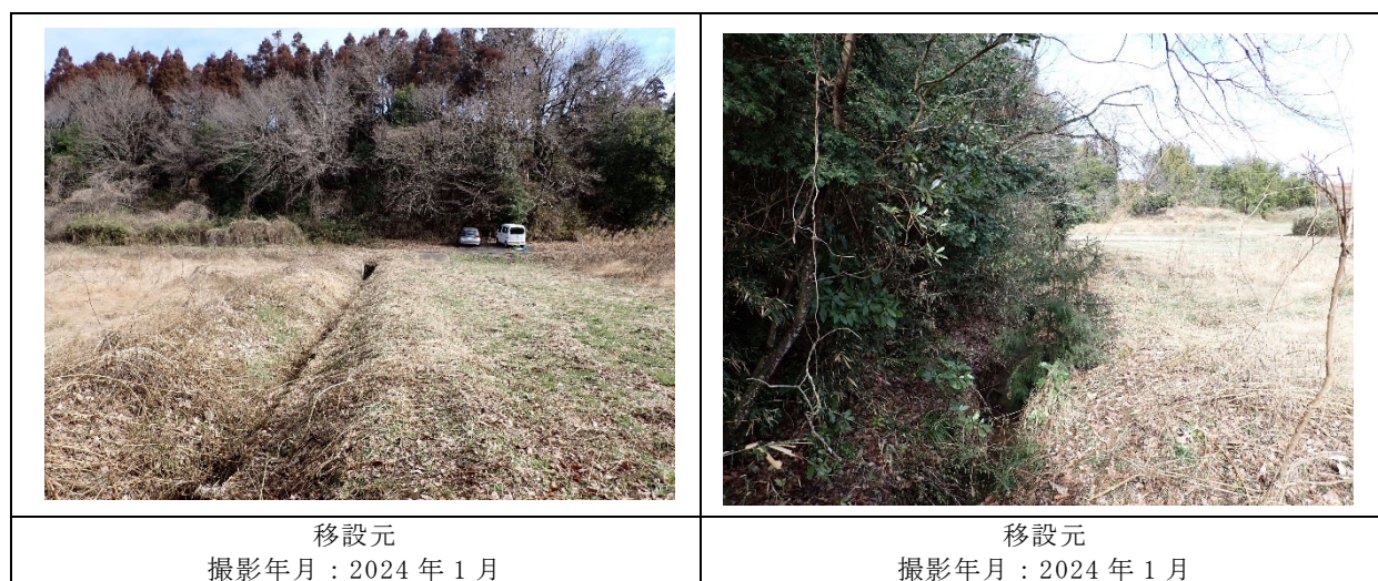
図 3.2-5 移設元の状況
