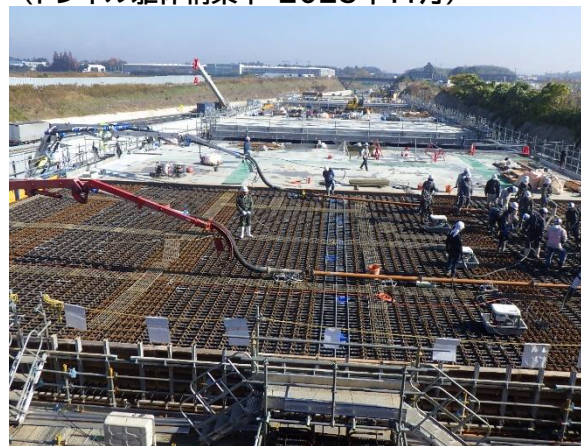
東関東自動車道・切り回し・地下道化 (トンネル躯体構築中: 2025年11月)
