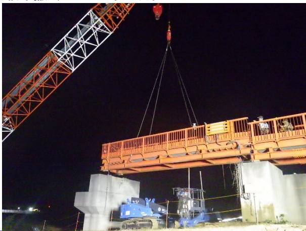
B滑走路延伸部造成整備 (進入灯橋梁撤去: 2025年11月)
