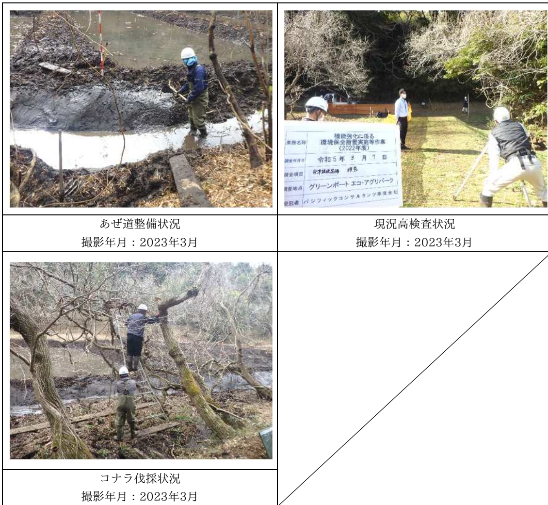
図 3.2-25(2) 環境整備作業状況
